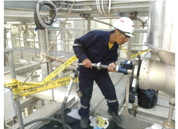
Maquinando con el equipo BTG Fuente: WP_000342
